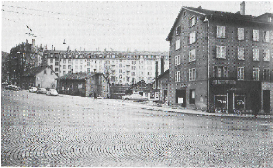
An der Röschiachstrasse. Von den Häusern im Vordergrund steht nur noch jenes ganz links, Röschiachstrasse 42
