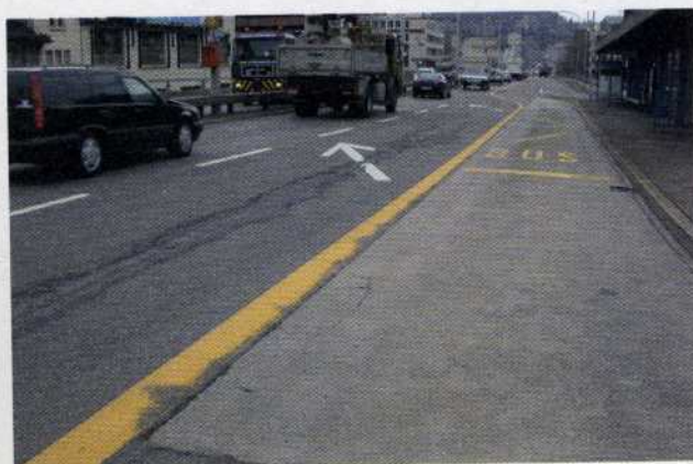
Gravierende Belagsschäden
