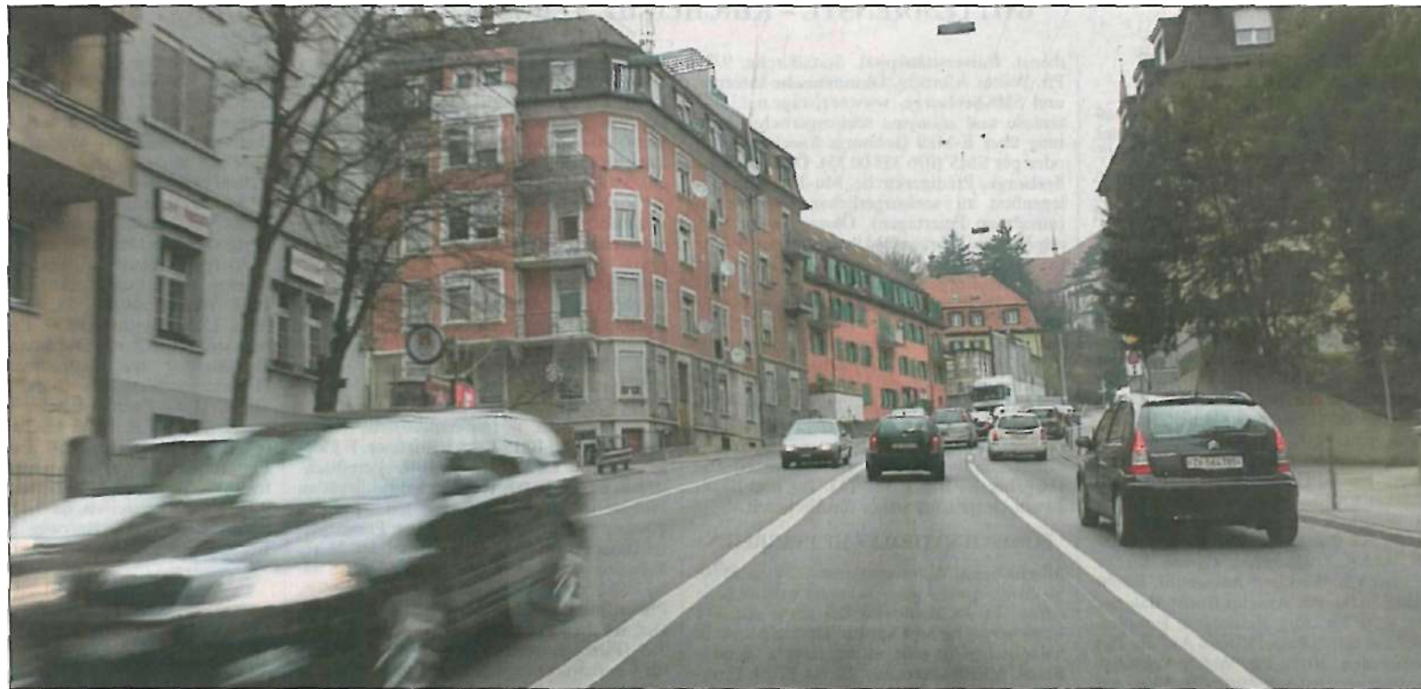
Der Waidhaldetunnel würde zulasten von zwei Fahrspuren ein Tram auf der Zürcher Rosengartenstrasse ermöglichen.
