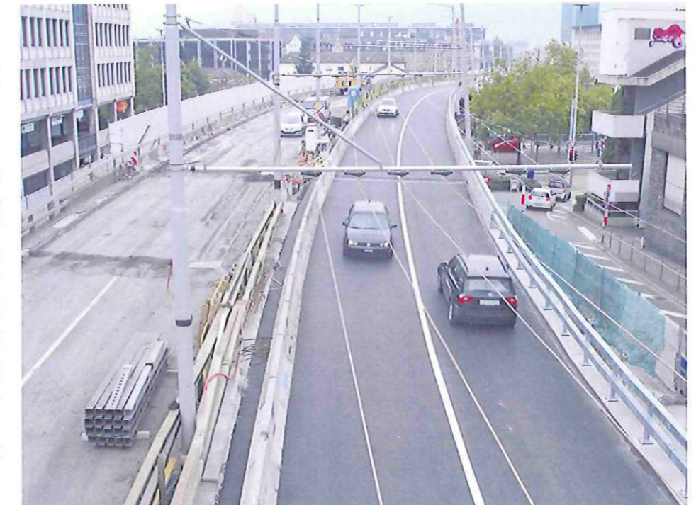
Bereits seit dem 11. Oktober wird der Verkehr über ein Teilstück der sanierten Hardbrücke geführt.
